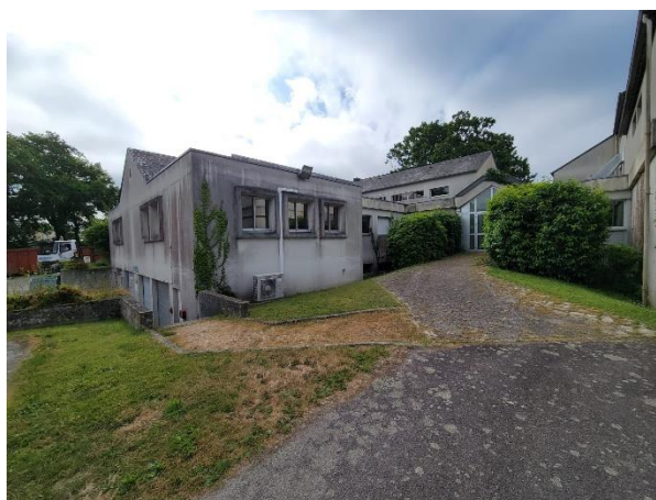
Aperçu du bâtiment
